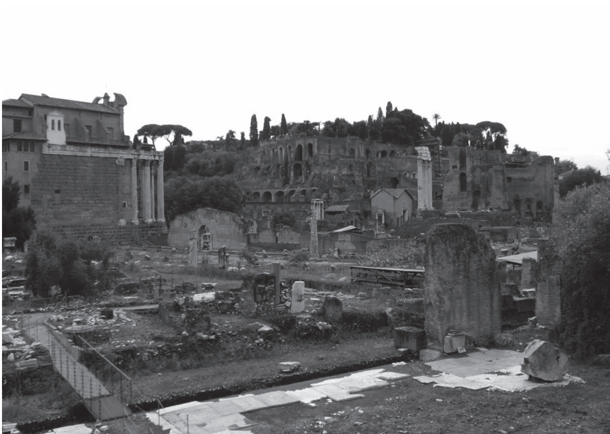
Abb. 7b: Rom, Blick von Norden über das Forum Romanum auf Substruktionen am Palatin
